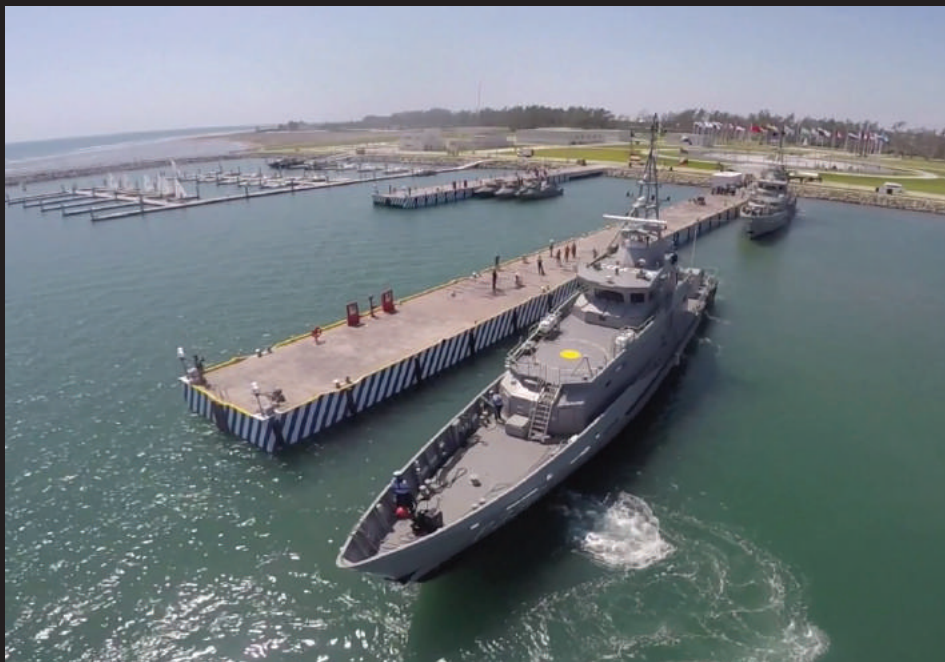
Vista aérea del muelle fijo.
