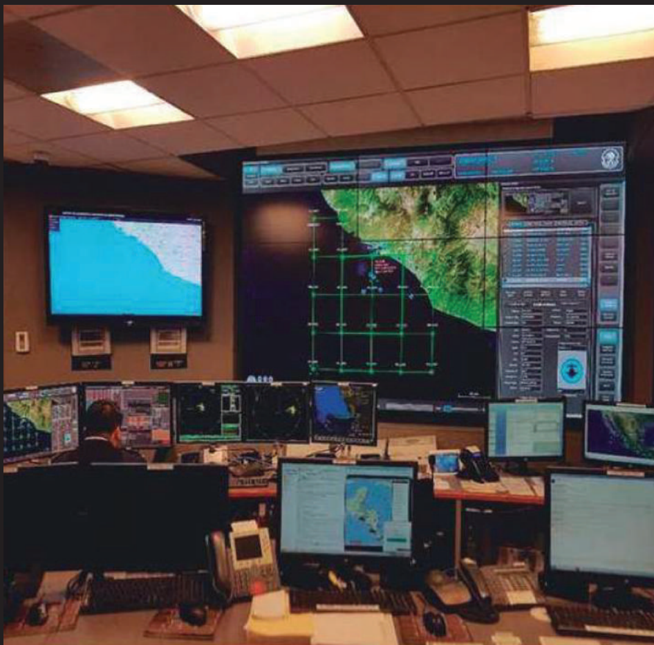
Instalaciones del Centro de Mando y Control.
