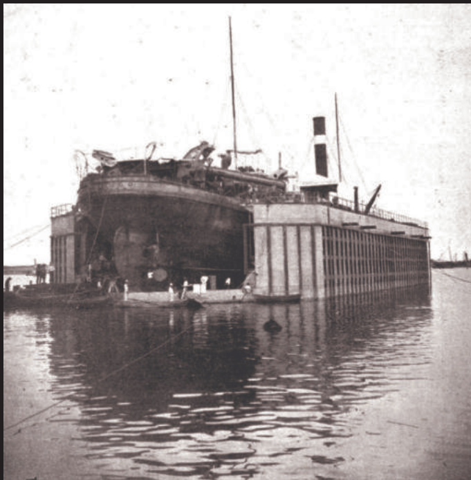
Dique flotante reparando a la draga México.
