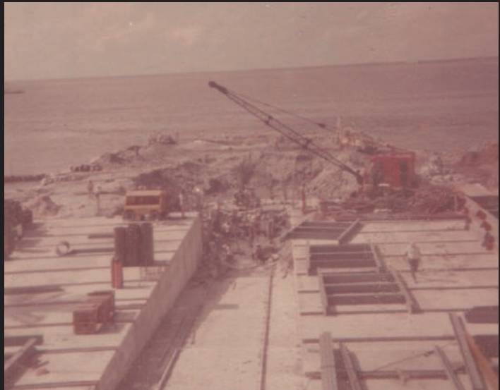
Inicio de la construcción de nuevo varadero 1981.
