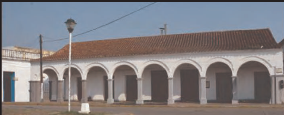
Fotografía actual de la sede del Colegio de Marina Tlacotalpan.
