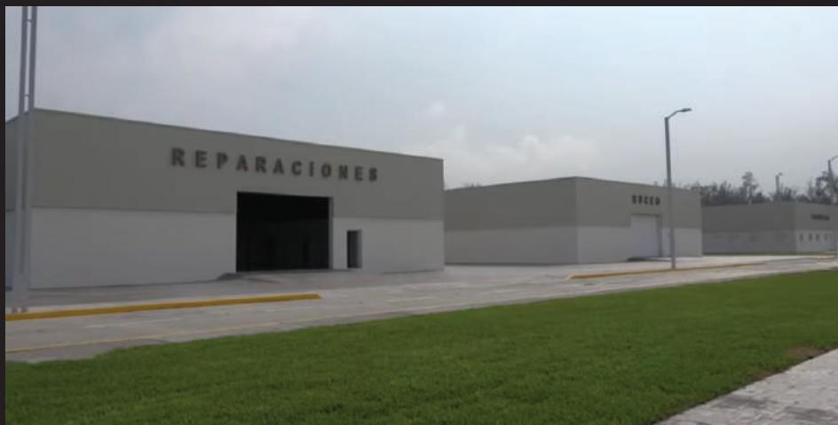
Taller de reparaciones y Estación de buceo.
