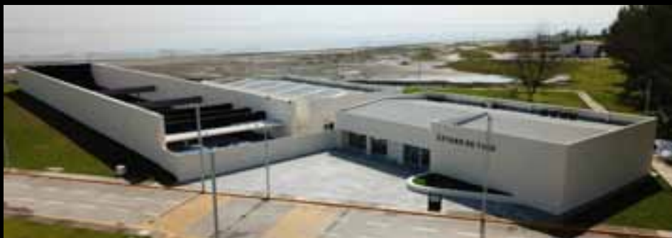
Vista aérea del edificio del Estand de Tiro.
