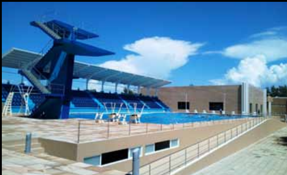
Nuevas instalaciones de la Alberca Olímpica.
