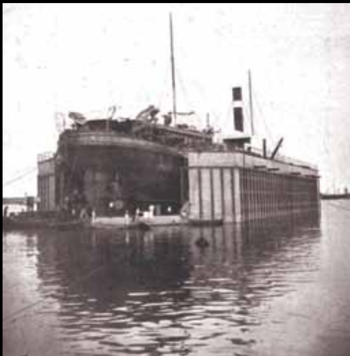
Dique flotante reparando a la draga México.
