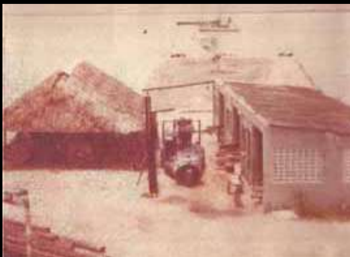
Construcción del primer varadero 1957.
