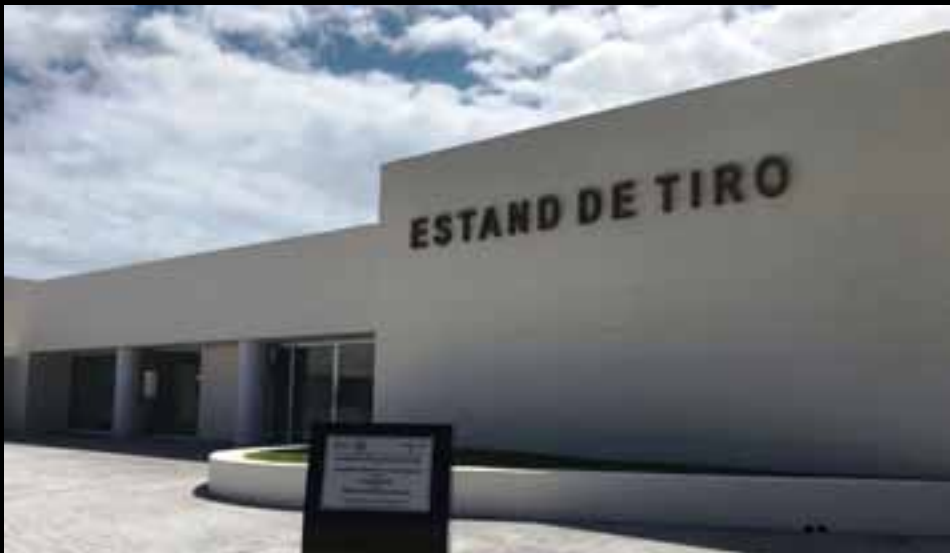
Fachada del edificio del Estand de Tiro.
