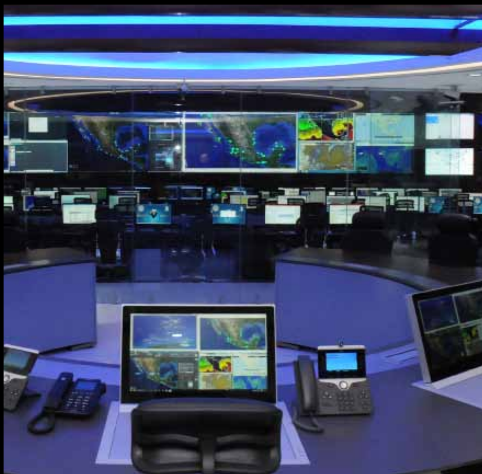
Instalaciones del Centro de Mando y Control.
